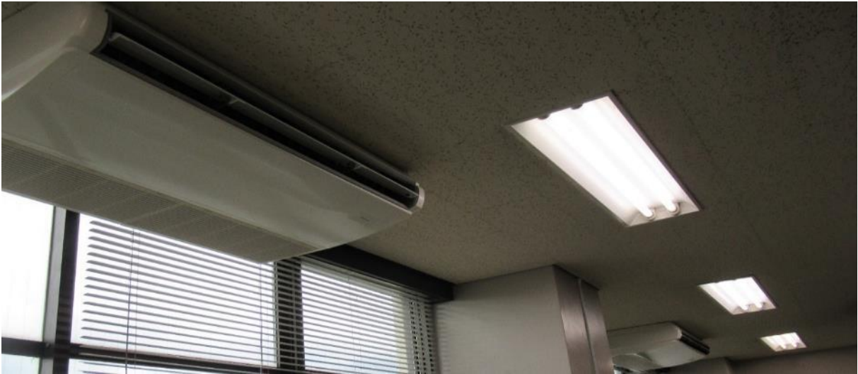
写真 2.2.14-1（パッケージエアコン室内機）設置
