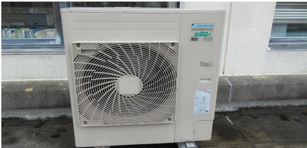
写真 2.2.14-2（パッケージエアコン室外機）設置
