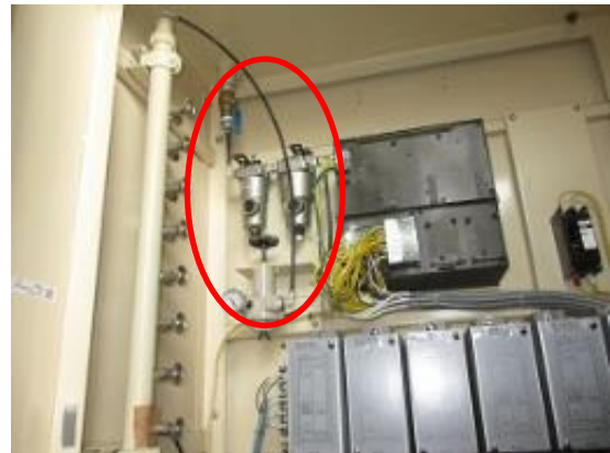
写真 2.2.6-2 エアフィルタ 設置後
