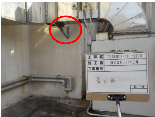
写真 2.2.3-2 ダクトサポート更新前
