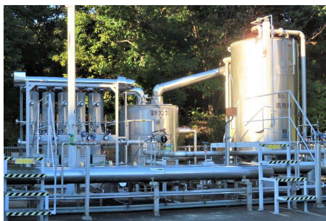
写真2.2.19-1 更新された小型多筒式蒸発器（左）既存の温水式蒸発器（右）
