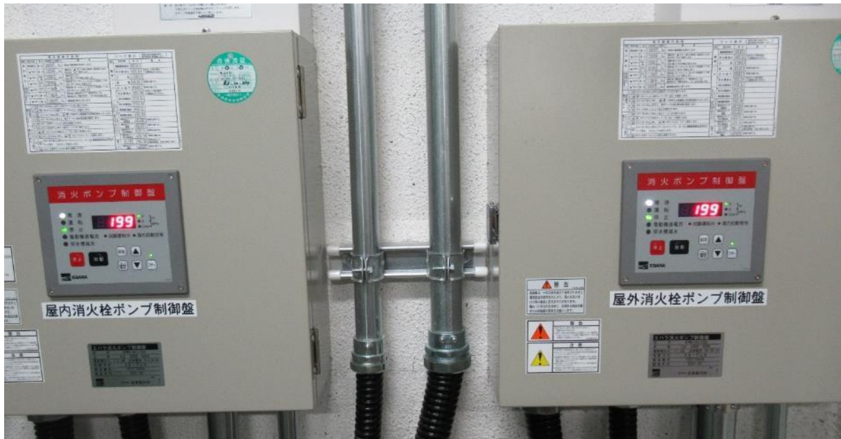
写真 2.2.15-3 屋内外消火栓ポンプ制御盤設置
