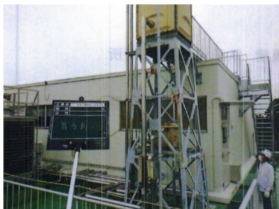
写真 2.2.8-1 高架水槽用架台 塗装前
