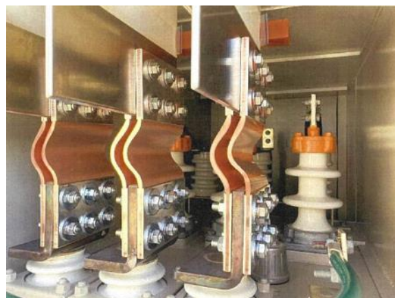
写真 2.2.20-4 バスダクト内状況
