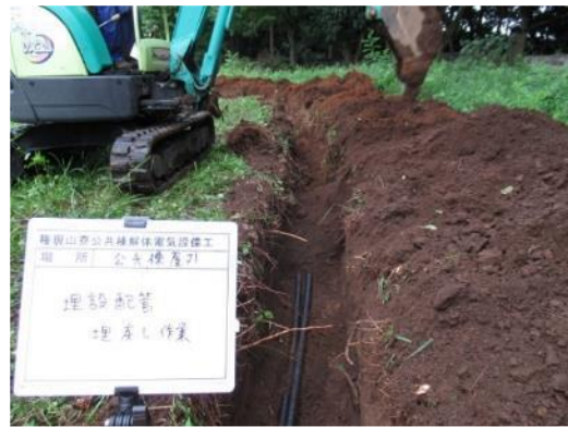
写真 2.12.14-2 権現山寮 埋設配管埋戻し
