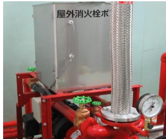
写真 2.2.15-2 屋外消火栓ポンプ更新後
