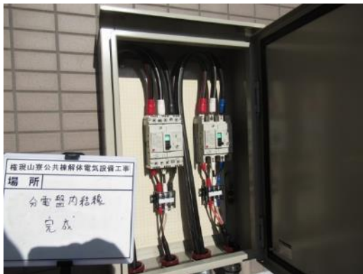
写真 2.12.14-3 権現山寮 分電盤設置
