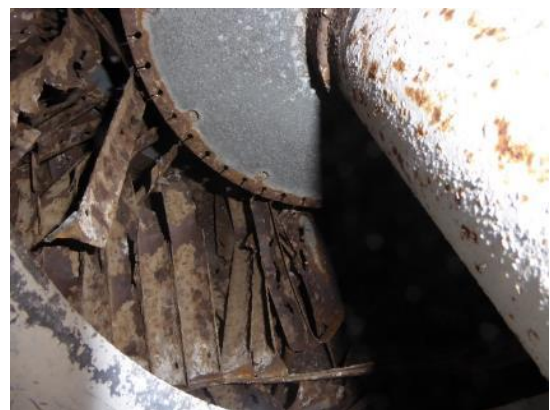
写真 2.10.3-1 空調機内部の羽根車（左側が脱落） 写真 2.10.3-2 羽根車フィンの脱落状況
