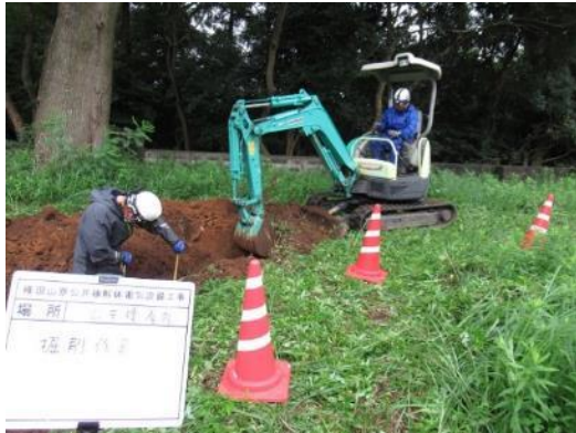
写真 2.12.14-1 権現山寮 掘削作業
