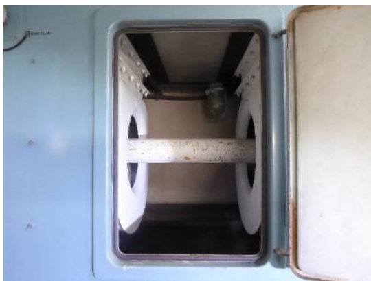
写真 2.10.3-1 空調機内部の羽根車（左側が脱落） 写真 2.10.3-2 羽根車フィンの脱落状況
