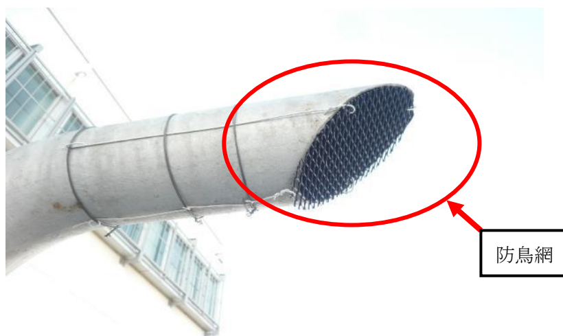
写真 2.2.17-1 防鳥網設置後
