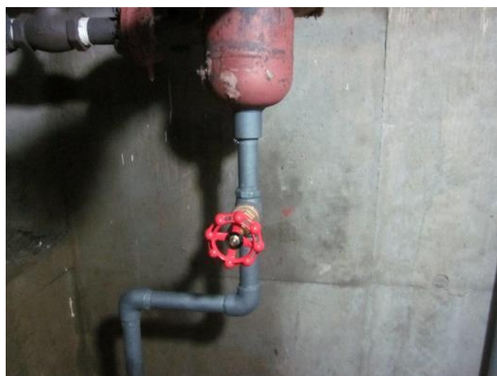
写真 2.2.11-2 第4研究棟西棟蒸気ドレンバルブの更新後
