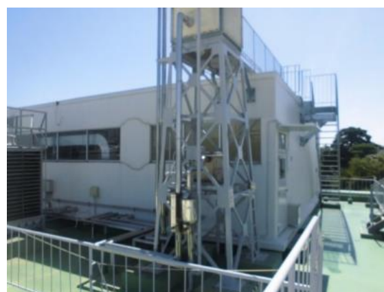
写真 2.2.8-2 高架水槽用架台 塗装後
