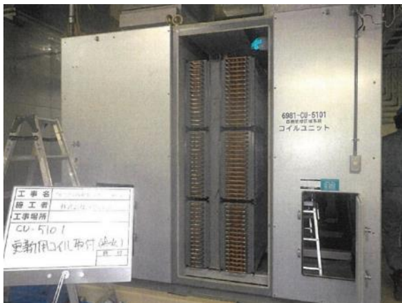
写真 2.2.20-1 MLF 冷温水コイル更新
